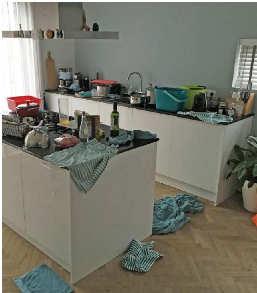
Lekkages zijn een risico in de bouw. Foto: Bureau Bouwpathologie.
